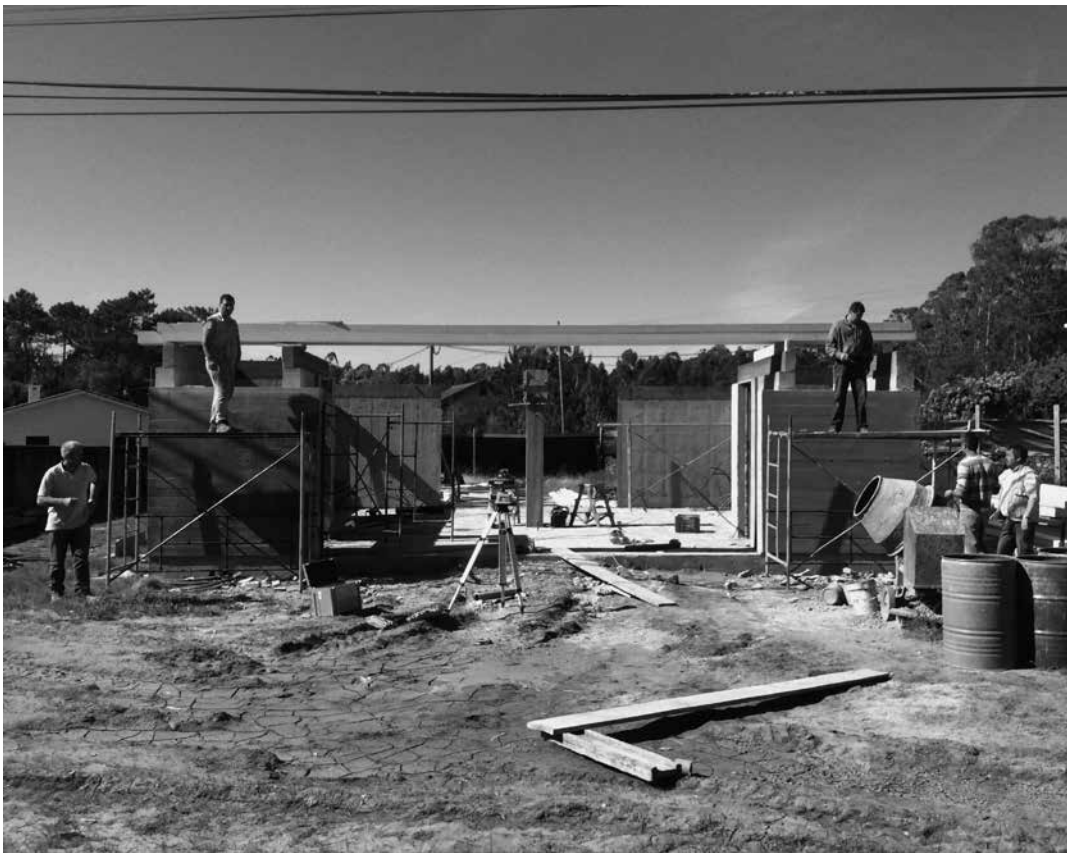
Obra na sua fase de estruturas – fotografia de Hugo Barros
