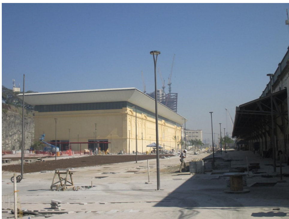
Aquário em construção
