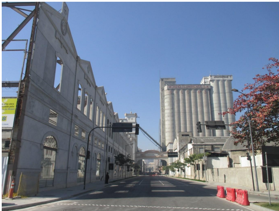
Armazém e silos Moinho Fluminense
